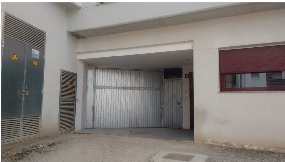
Vista accés petonal i rodat edifici C/Trullets 18 per aquest espai lliure
