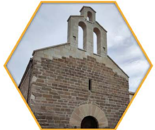
Rehabilitació i reconstrucció de l'antic campanar de l'església vella de Penelles.
